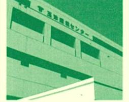
昭和56年より共用開始している下水処理場。西区の21.5万人の汚水を処理し、綺麗な水にして明石川へ放流している。併設する吉田ポンプ場は、周囲255haに降る雨水を明石川へ排除する役割を担っている。
